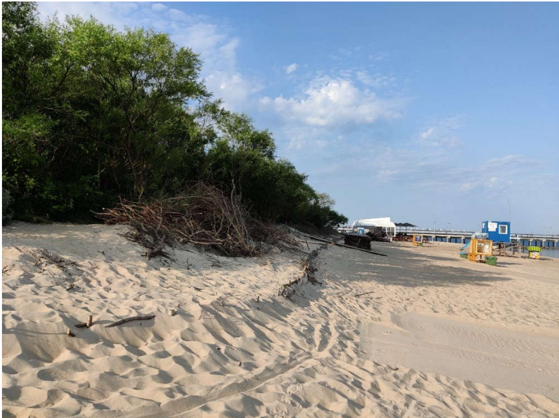
3.3.2 pav. Apsauginio kopagūbrio būklė Ražės upelio – Palangos tilto ruože 2021 m. birželio mėn.
