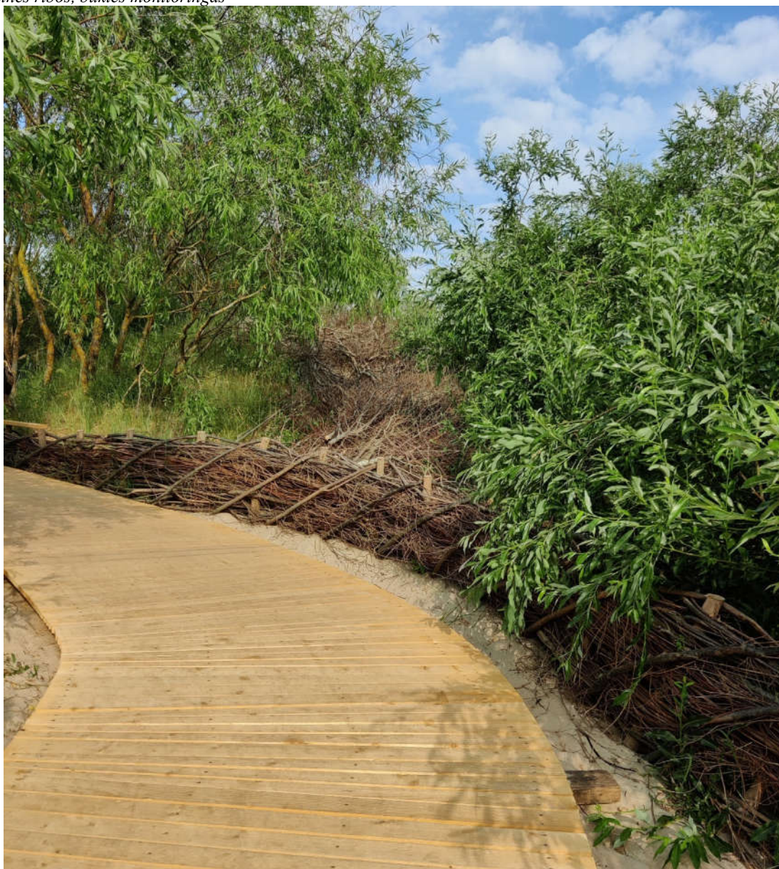
5.1 pav. Puikiai sutvirtinta užkopė – žabtvorė ir šlaitas - šakų klojiniais Palangoje (ties vaikų žaidimo aikšte, Šermukšnių g.)
