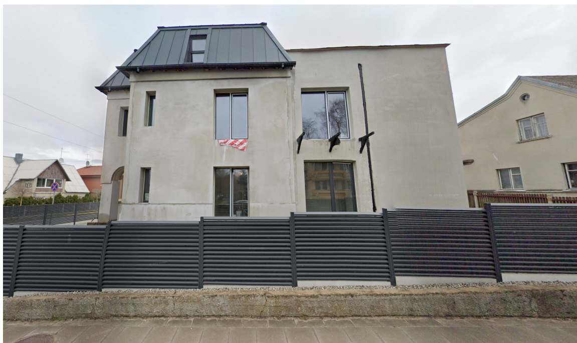
Pastatas Plytų g.15, Palanga
