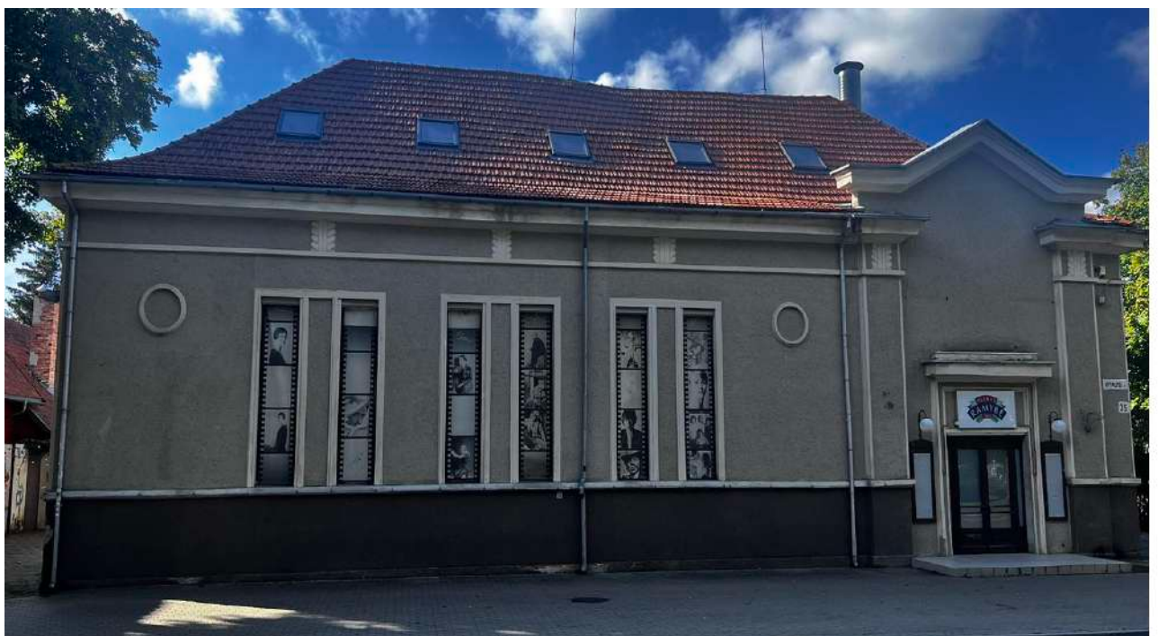
4 pav. Pastato rytinis fasadas nuo Vytauto gatvės pusės
