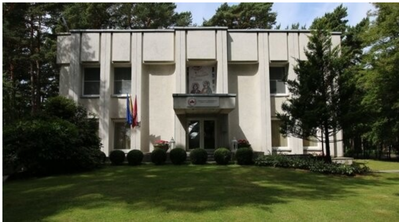
Žemės sklypas Gedimino g. 5, Palanga / mokslo paskirties pastatas
