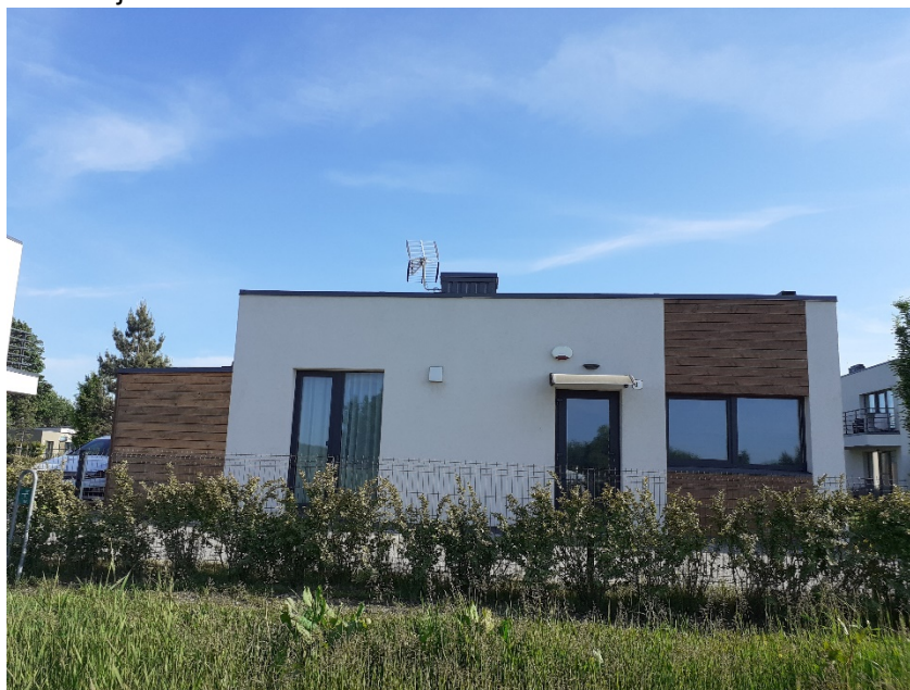
1 pav. Šiaurinis fasadas
