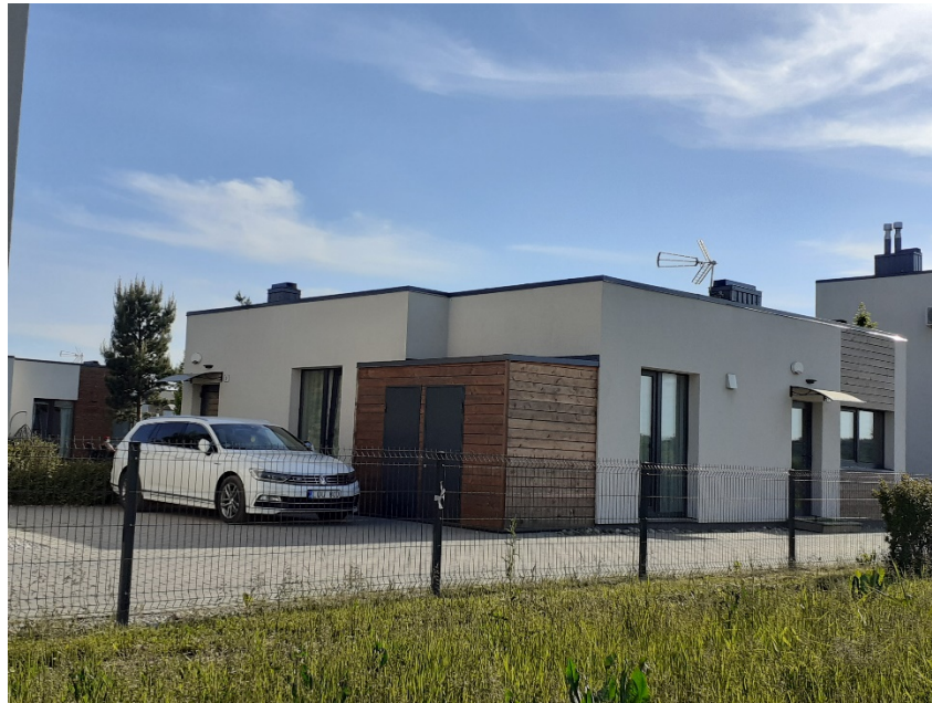
2 pav. Rytinis fasadas
