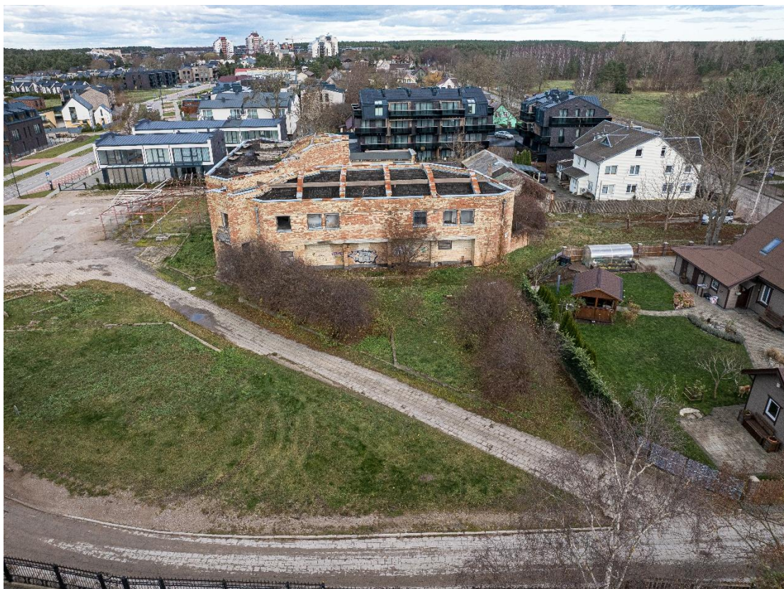
Fotofiksacija iš paukščio skrydžio nuo Jazminų gatvės.
